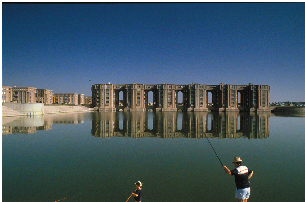
Le Viaduc, sur le bassin de la Sourderie, au début des années 1980
